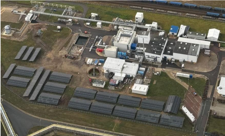
Abbildung 1 PV-Anlage Alberdingk Boley
